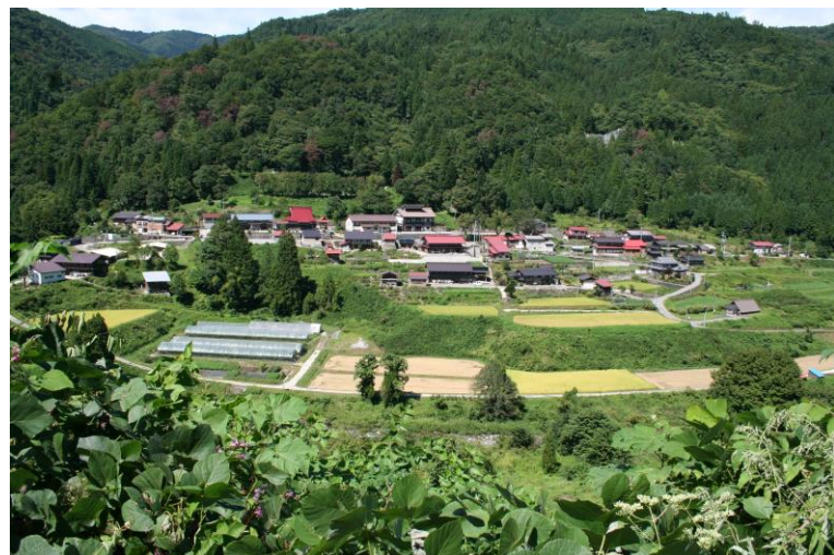
【羽根集落】 河合町、宮川町は豪雪地帯。大きな屋根の家屋が多いが積雪対策は万全。
